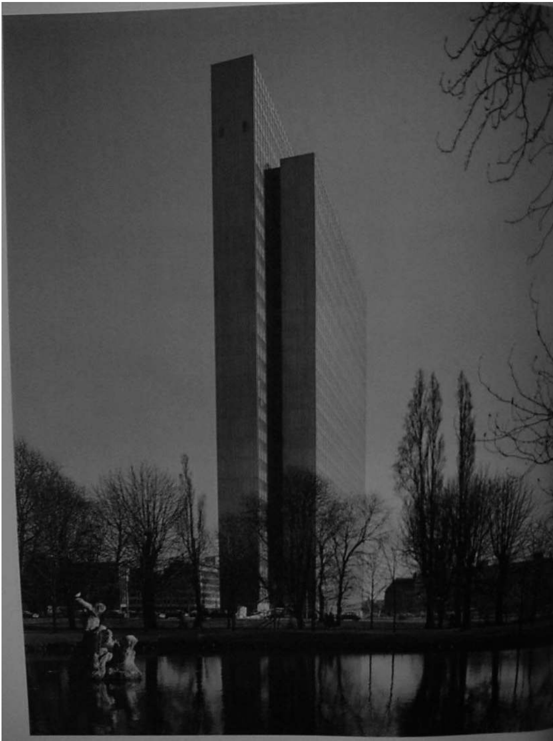
Tres paralelepípedos reales. Edificio de Phoenix-Rheinrohr AG en Dusseldorf. Foto: Arno Wrubel/HPP.
